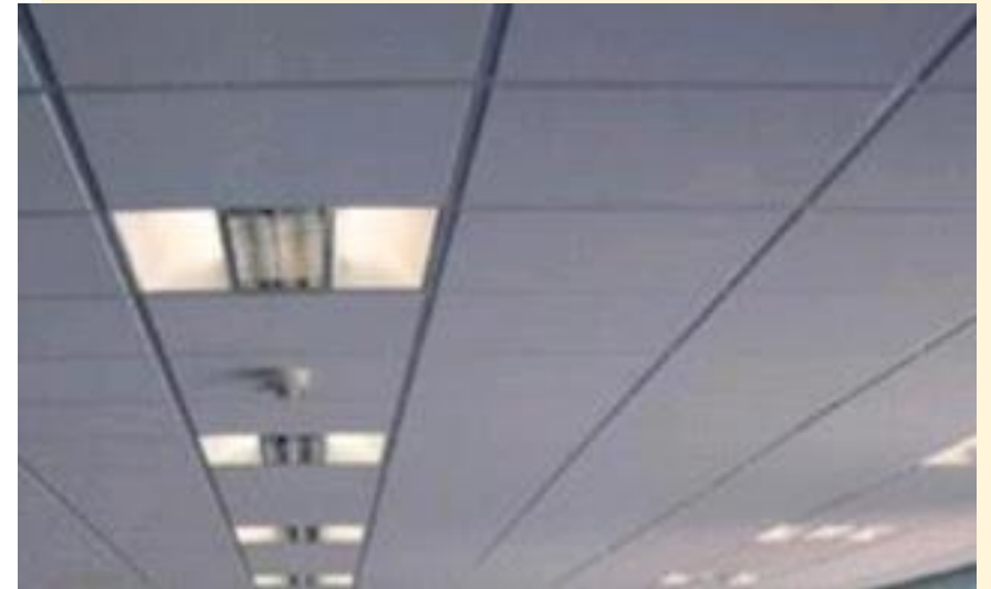
2. Aplikasi Plafon Eternit-Asbes
