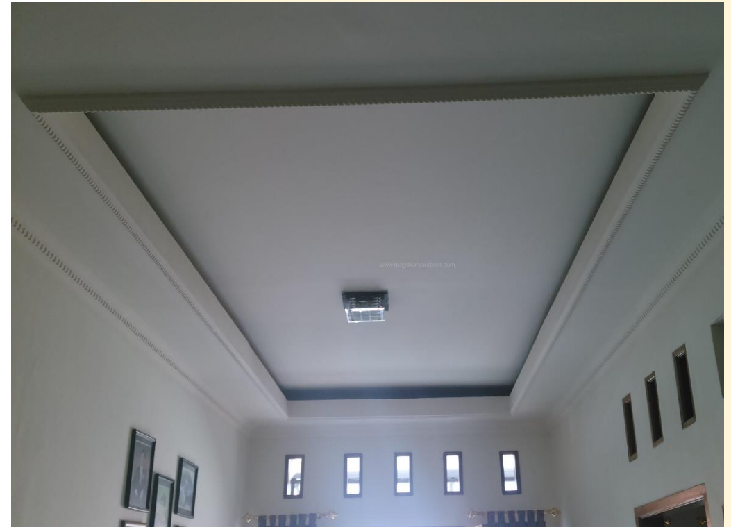
4. Aplikasi Plafon Gypsum
