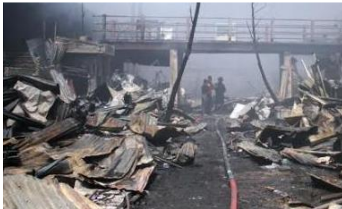
Gambar 49. reruntuhan bangunan pasca kebakaran (Jateng.tribunnews.com)
